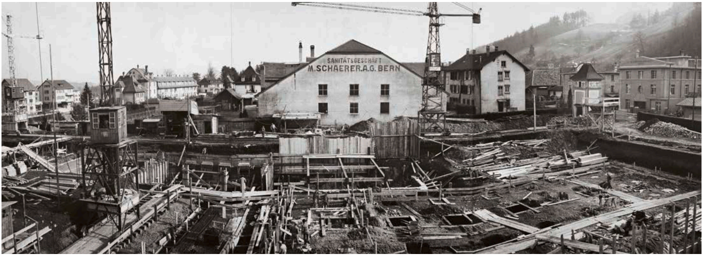
Abb. 11: Die Baustelle des neuen Betriebsgebäudes der Landestopographie in Wabern, 1939 (swisstopo, Bildsammlung).
